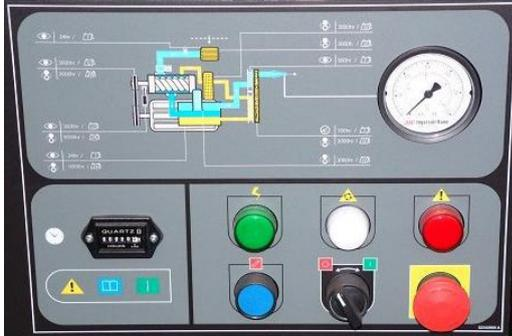
Los compresores de la serie SSR UP incluyen un módulo de control estándar que proporciona el arranque, parada, control de la capacidad y de la presión, junto con controles de funcionamiento y seguridad para el conjunto completo.
