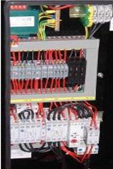
Se monta un arrancador estrella-triángulo a 380/415v/3f/50Hz integrado en el compresor en un armario con protección IP-55. El arrancador incluye un transformador a 110 V para el circuito de mando y todo el resto de componentes. El circuito de mando posee dos sistemas de corta-circuito:
